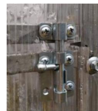
Spojovací zarážka dveří a okna
